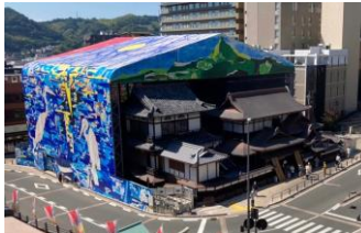
道後温泉本館 (保存修理工事中)
