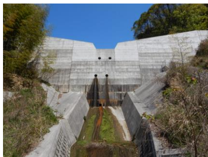
既設の砂防ダム
