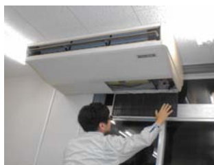
空調フィルター清掃
